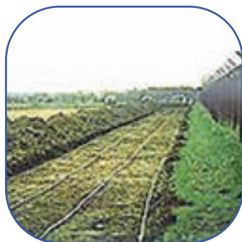
SISTEMI INTERRATI IN GRADO DI INDIVIDUARE INTRUSIONI GIÀ NEL PERIMETRO DELLA CASA
